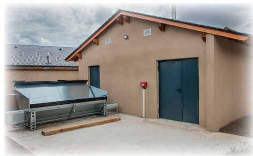
Zone de livraison devant le local chaufferie, avec trémie de déchargement.
