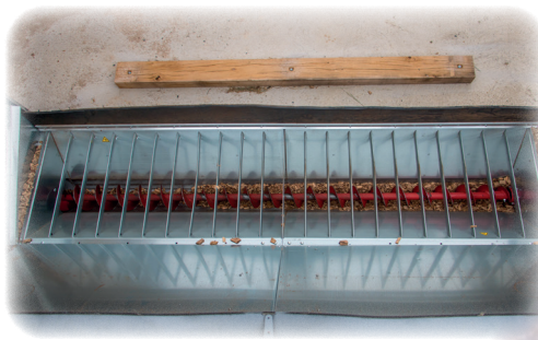
Trémie ouverte pour le bannage, avec une cale d'arrêt pour le camion de livraison.
