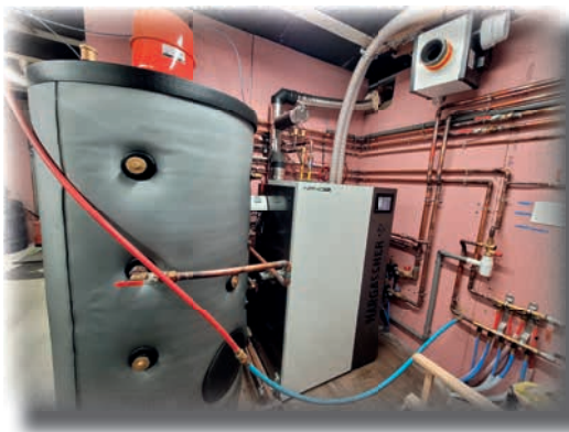
Chaudière et ballon tampon pour le chauffage et l'ECS (cylindre gris)
