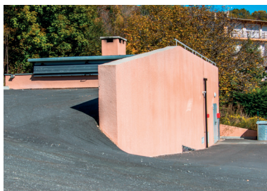
Bâtiment avec silo (en haut) et chaufferie (en bas)
