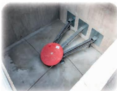
Dessilleur rotatif avec 2 vis d'extraction, une pour chaque chaudière.
