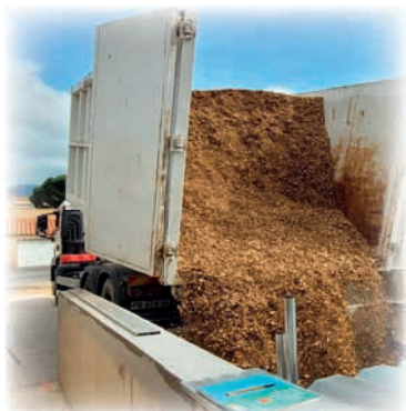
Première livraison de bois déchiqueté, bennage gravitaire dans le silo semi-enterré
