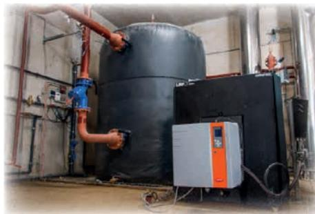
Ballon tampon de 5 000 litres, avec canalisations départ et retour chaufferie, et chaudière d'appoint-secours (à droite).
