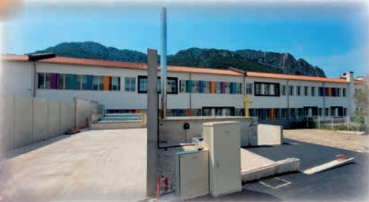
A l'arrière du collège, accès au silo et à la chaufferie surplombée par ses 2 cheminées
