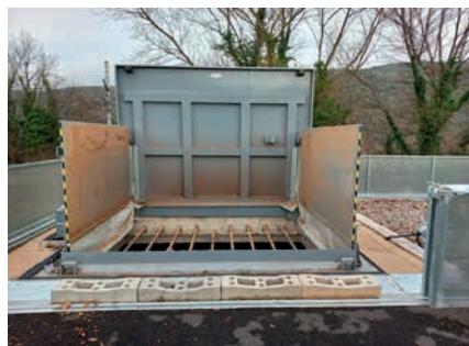
Silo enterré avec trappe basculante
