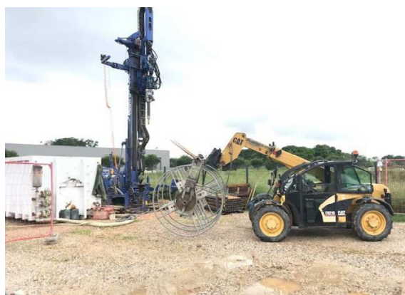
Réalisation des forages à proximité du futur bâtiment
