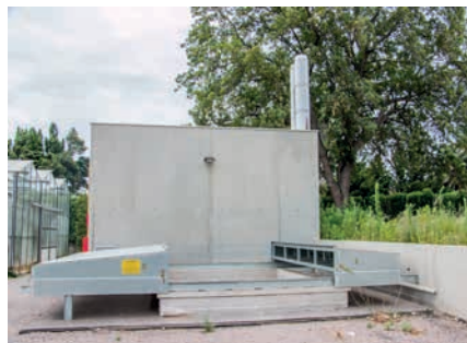
Silo enterré avec trappe coulissante
