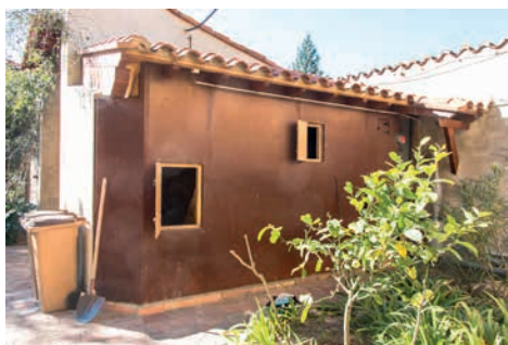
Silo hors-sol avec trappes de visite
