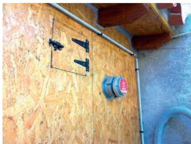
Raccord de remplissage du silo
