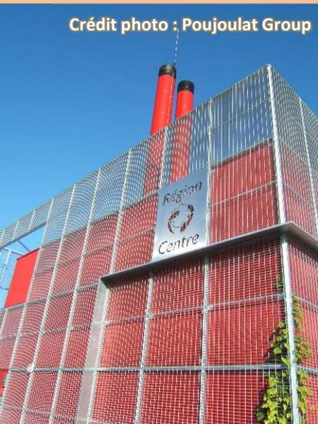
Le conduit de fumées a pour objet de garantir le bon fonctionnement de la chaudière bois en assurant un bon tirage, de permettre l'évacuation des fumées dans l'atmosphère et de résister aux hautes températures, à l'humidité et aux aléas climatiques.
