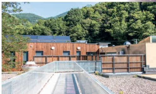
Panneaux solaire thermique sur le toit pour la production de l'eau chaude sanitaire.
