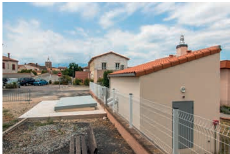
Local regroupant la chaufferie et le silo, et à gauche la trémie de remplissage.
