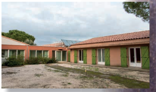
Panneaux solaire thermique pour le chauffage de l'eau chaude sanitaire.
