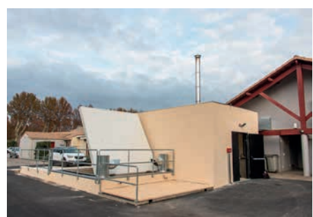
Local chaufferie (à droite) + silo enterré avec trappe ouverte (à gauche)
