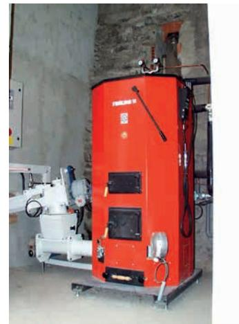
Chaudière Seccacier-Fröling et sa vis d'alimentation, 35 kW
