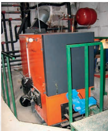
Chaudière Heizomat, 150 kW
