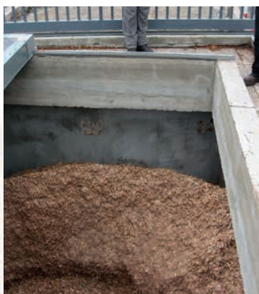
Silo semi-enterré fermeture par capot coulissant
