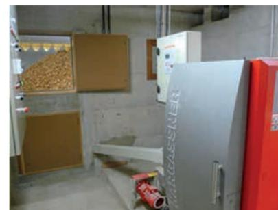
Chaudière Hargassner 45kW alimentée par une vis sans fin
