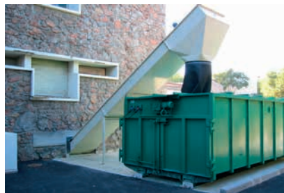
Système de convoyage et stockage des cendres
