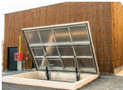
Silo enterré avec trappe basculante
