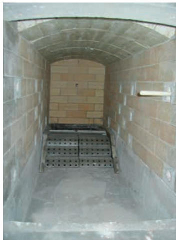
Foyer chaudière à gradins mobiles
