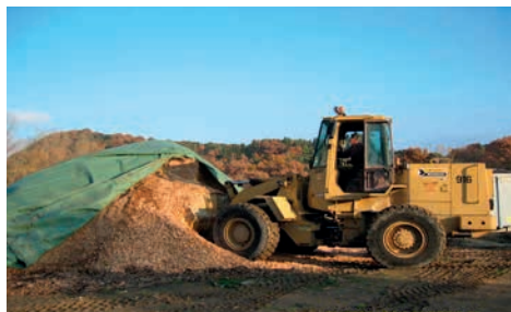
Plateforme Vinça: stockage sous bâche
