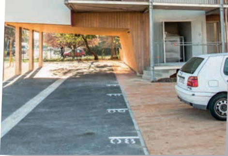
Accès pour livraison + silo
