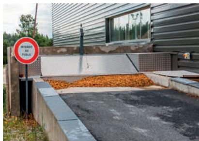
Rampe d'accès et trémie intermédiaire
