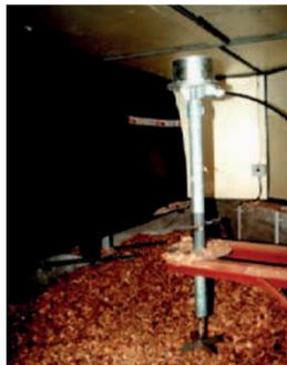
Trémie dans laquelle se vide le conteneur à racleurs. Les plaquettes bois sont ensuite acheminées depuis cette trémie jusqu'à la chaudière par un système de convoyage par vis sans fin.
