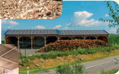
Hangar de stockage Osséja
